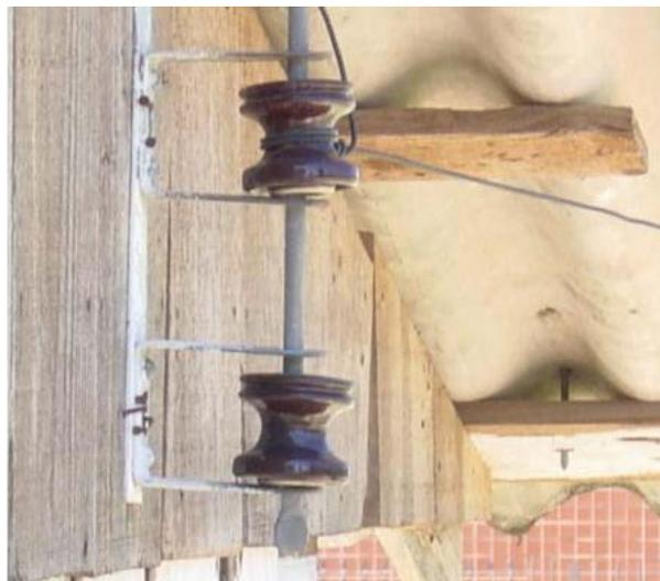
Figura 2.11 – Isolador elétrico em serviço
